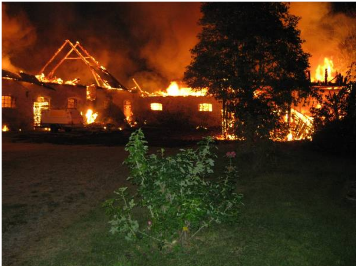
Bild 1. Ladan efter att taket brunnit igenom.
