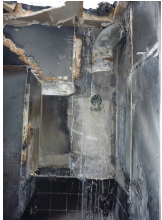
Bild 6 Brandskadorna ovan spisen
