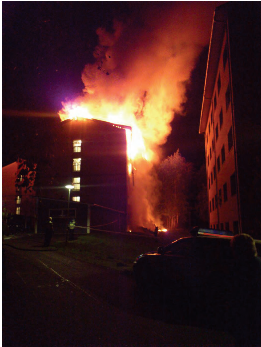
Bild 2 Kl 02:55 tas denna bild av en granne. Takfoten och hela takkonstruktionen har kollapsat. Ingen brandspridning till lägenheterna förekommer.
