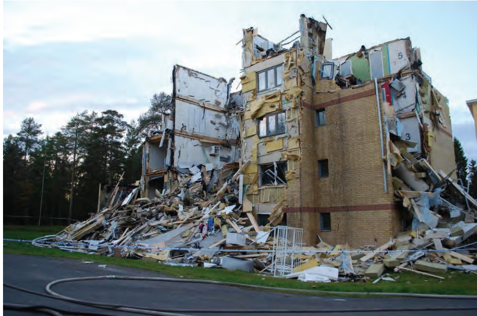
Bild 4 Brandplatsen, vid undersökningstillfället hade dock det mesta av rivningsmassorna transporterats bort.
