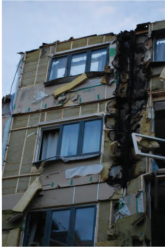
Bild 20 Brandspridning längs fasad innanför teglet
