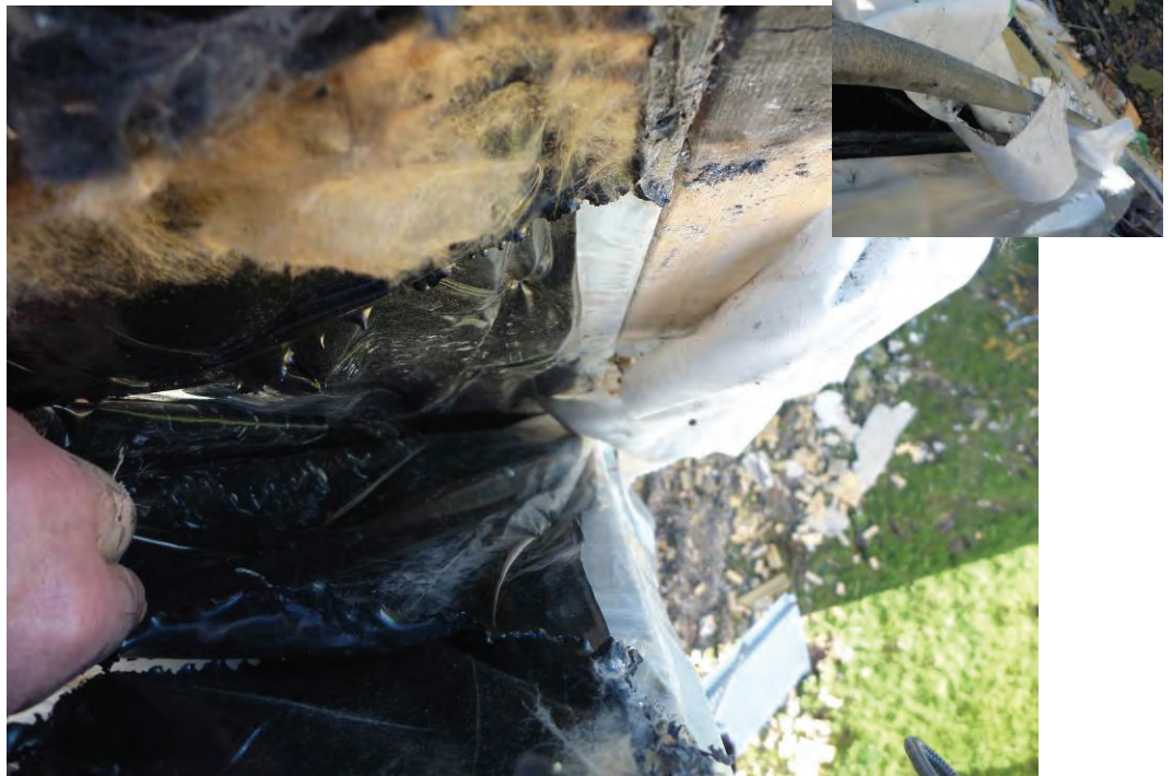
Bild 21 Plasten mellan modulerna vid ytterväggen med bottningslisten inklipt.
