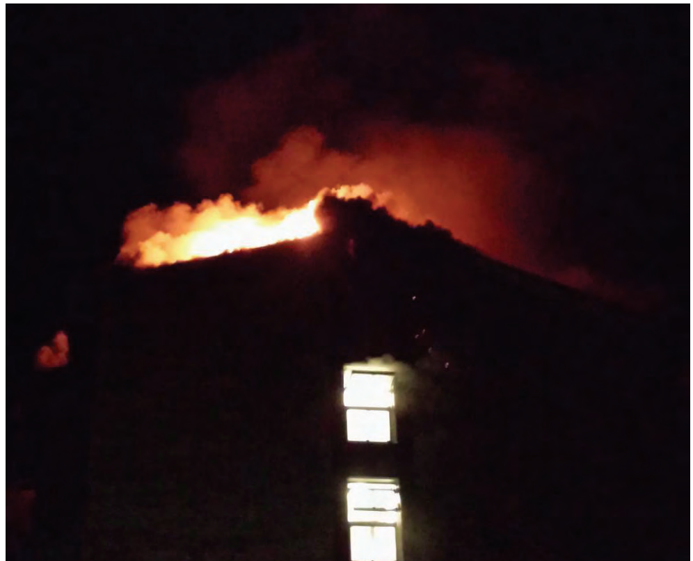
Bild 1 En beskuren del av en bild som togs 02:26 av en granne. Bilden visar att det har brunnit genom vid taknocken redan vid denna tidpunkt.
