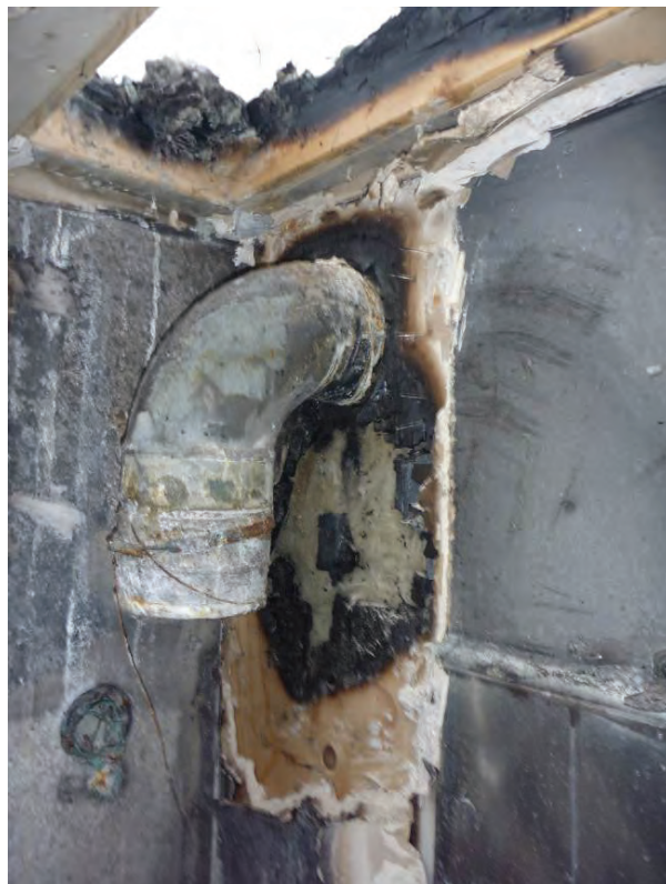
Bild 11 Antändning avplywoodskivan mellan gipsskivorna i schaktväggen
