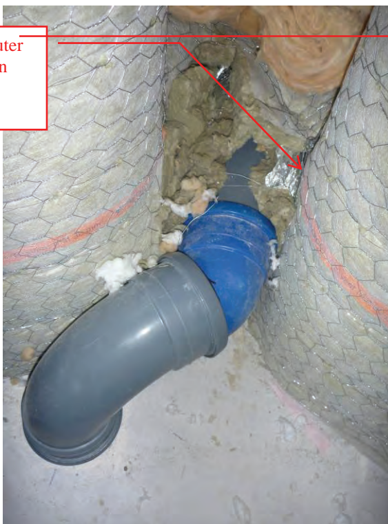
Bild 15 Ovan schakttoppen på referensobjektet
