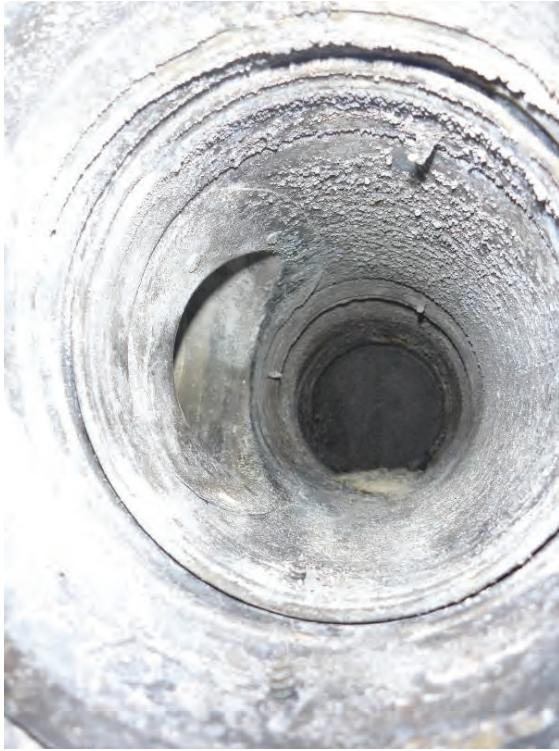
Bild 10 Imkanalen från brandlägenheten
