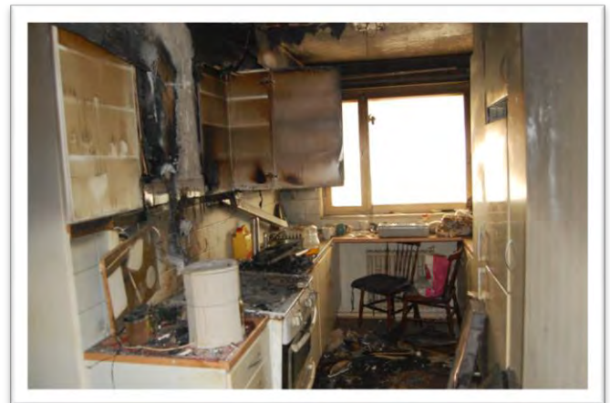
Bild 4. Brandens startutrymme. Fläkt och köksinredning har tagits bort av rökdykarna.
