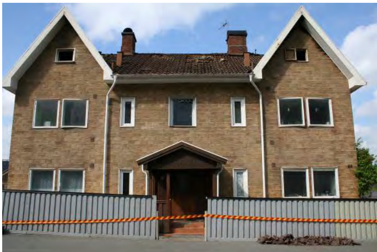
Bild 1. Fastighetens östra sida mot [redacted] .
