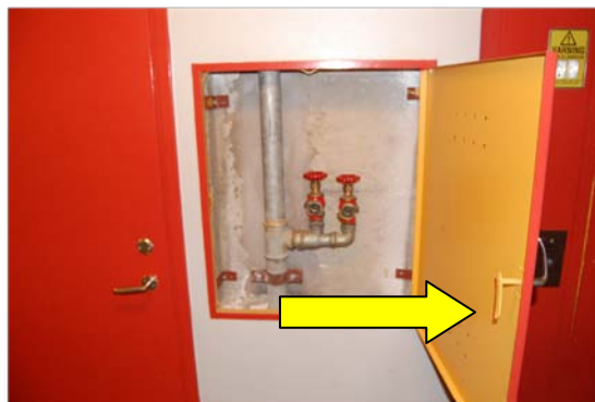
Bild 6. Stigarledningsluckan på femte våning Galileis gata.
