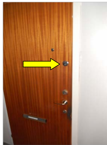
Bild 7. Lägenhetsdörren med tillhållarlås.
