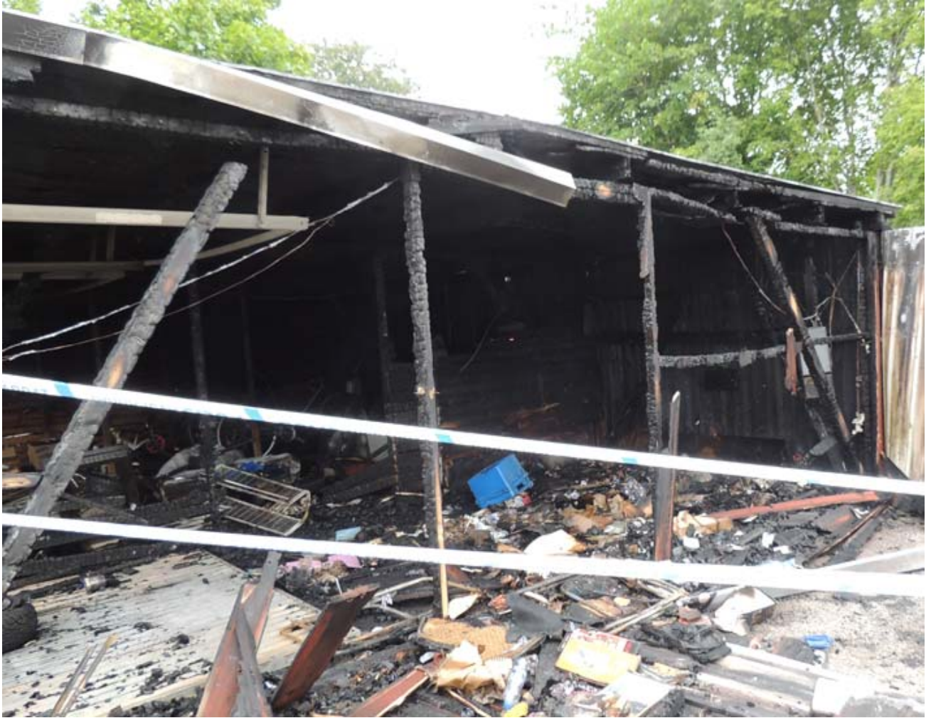
Bild1: Garaget längst till höger i garagelängan
