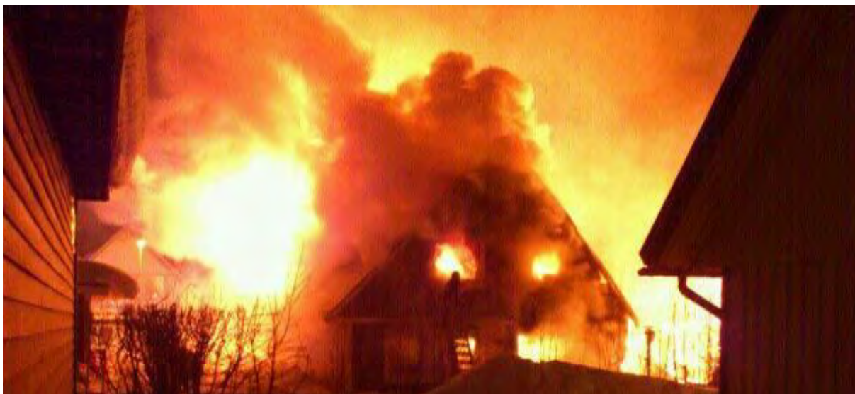
Figur 4, 01:21 räddningstjänstpersonalen har fått ut personen och byggnaden är på väg till övertändning. (med tillstånd från upphovsrättshavaren)
