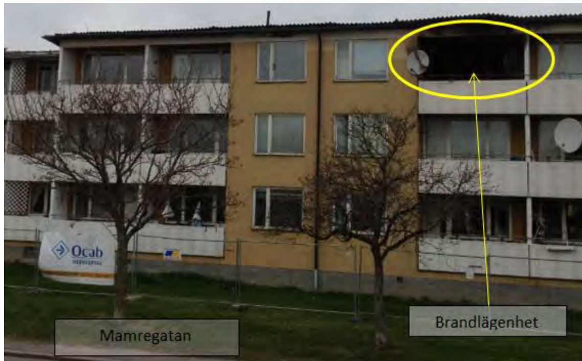
Bild tagen från Mamregatan med brandlägenheten markerad.
