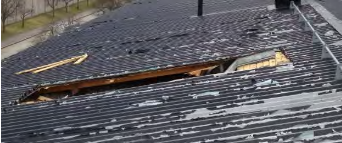
Bild på yttertak bestående av spontat virke, takpapp och takplåt vilande på en enkel regelkonstruktion.
