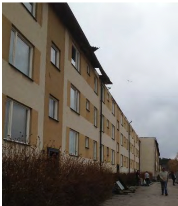
Bild på fastigheten efter branden med uppgång 2 i förgrunden
