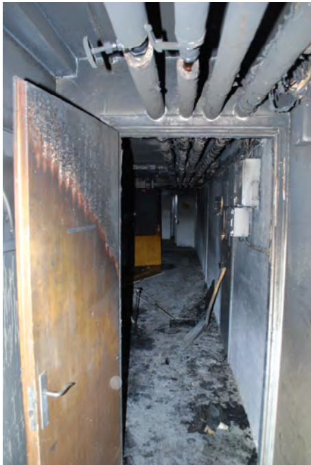
Figur 4. Dörr mellan startutrymme i källarplan och trapphus 5 A.
