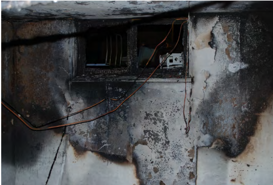
Figur 3. Brandutsatta väggar och tak vid initialbrand,
