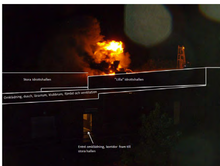
Bild 13: Visar nivåskillnaderna i byggnaden, samt entré till omklädningsrum.
