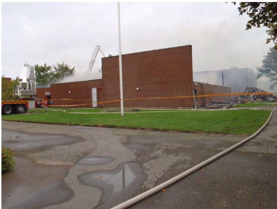
Bild 1: Visar idrottshallen från den östra sidan, ca 10h efter brandstart.
