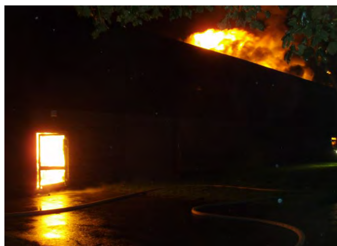
Bild 7: Lilla idrottshallens norra sida, ca 40 minuter efter att RTJ kommit fram.
