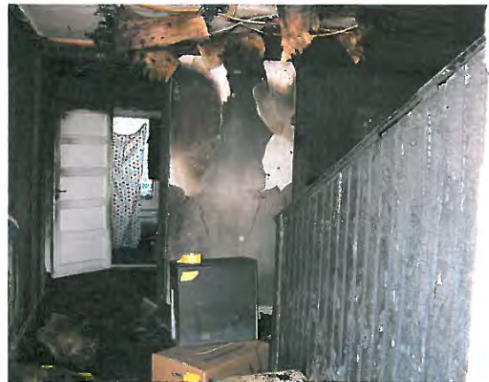
Bild 2 Hallen med trappa till övervåning till hö i bild.
