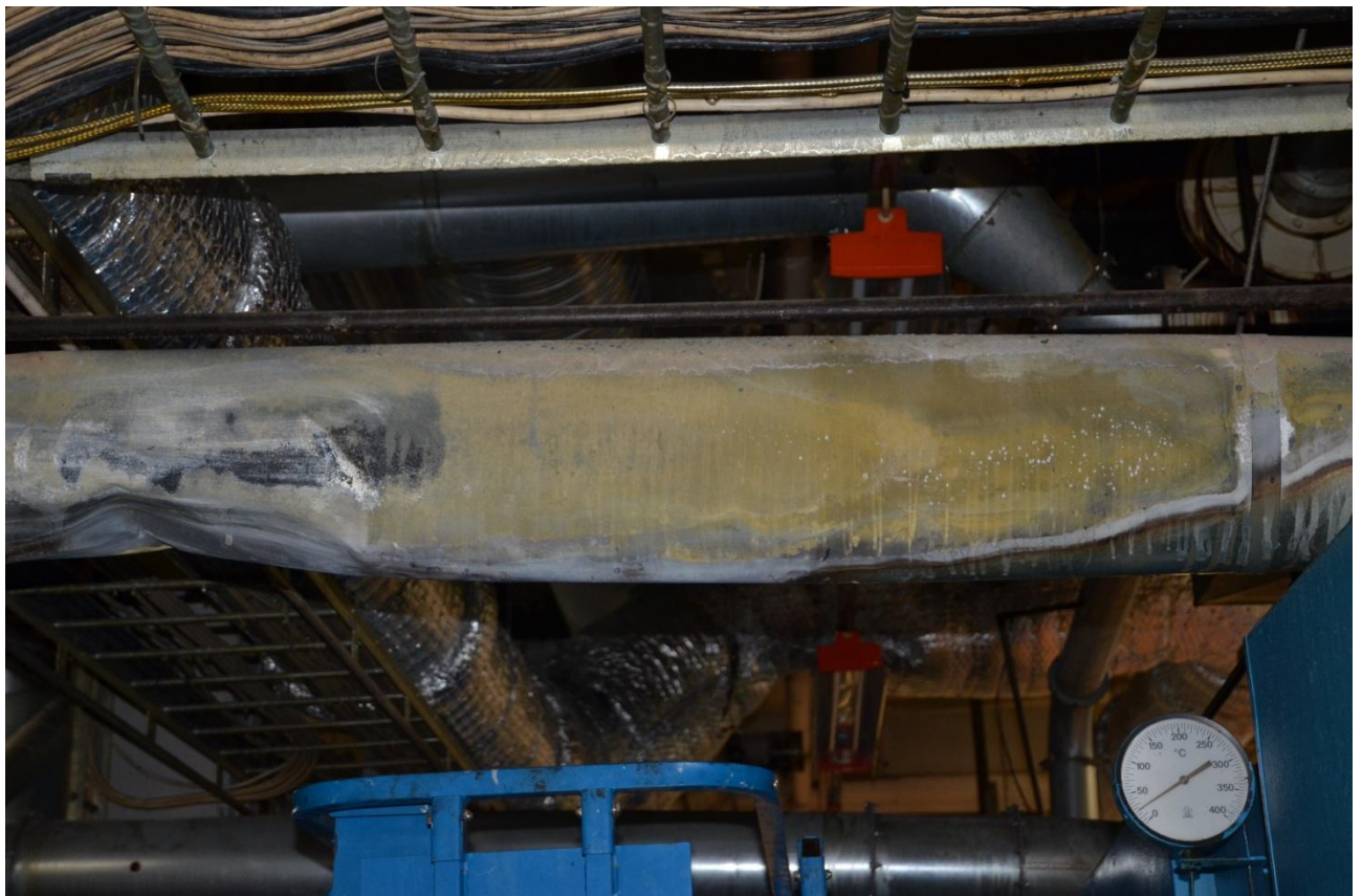
Brandskadad ventilationskanal
