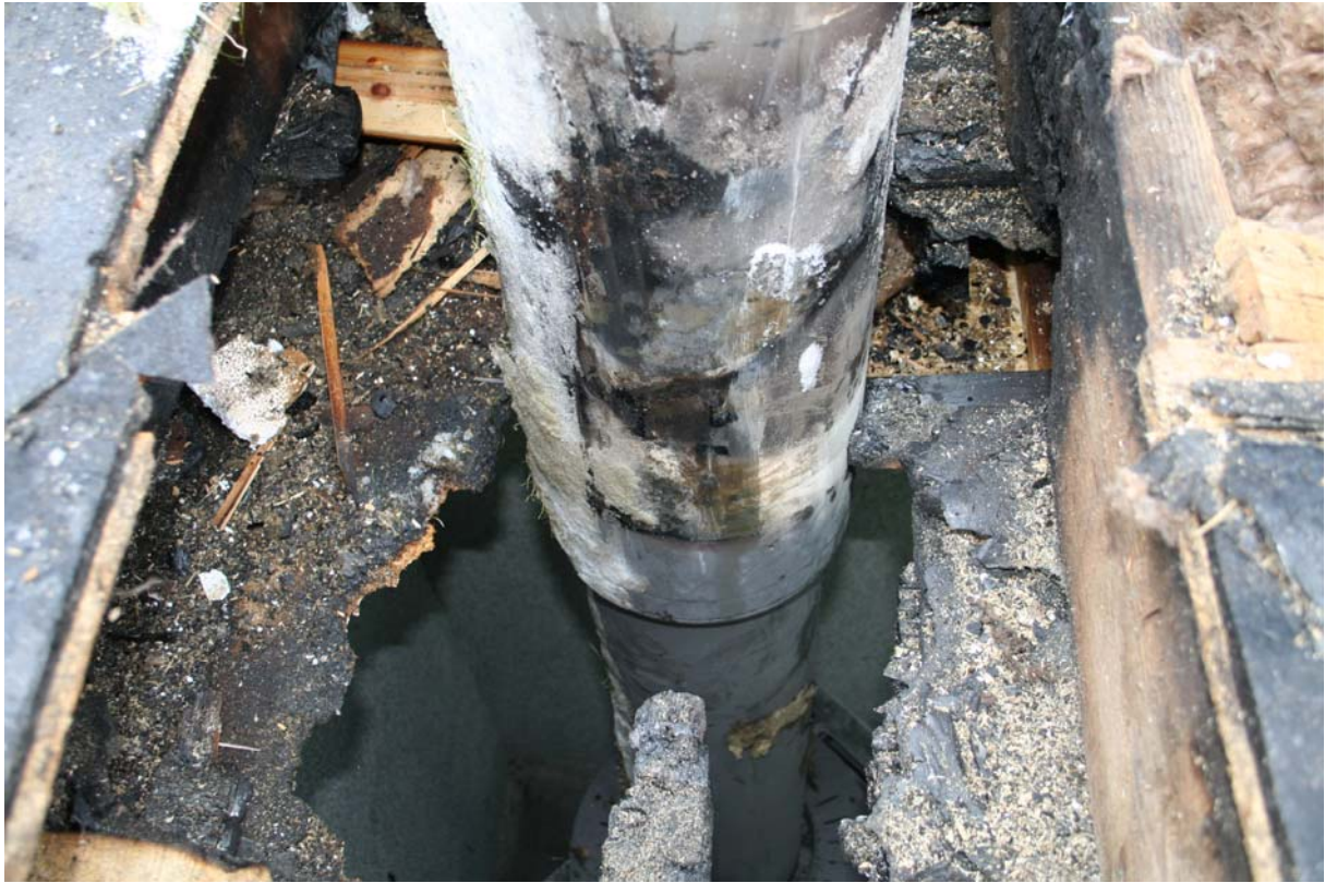
Bild 2. Bjälklaget och skorstenen sedd från ovan.
