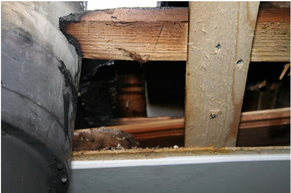
Bild 3. Bjälklaget och skorstenen sedd underifrån.
