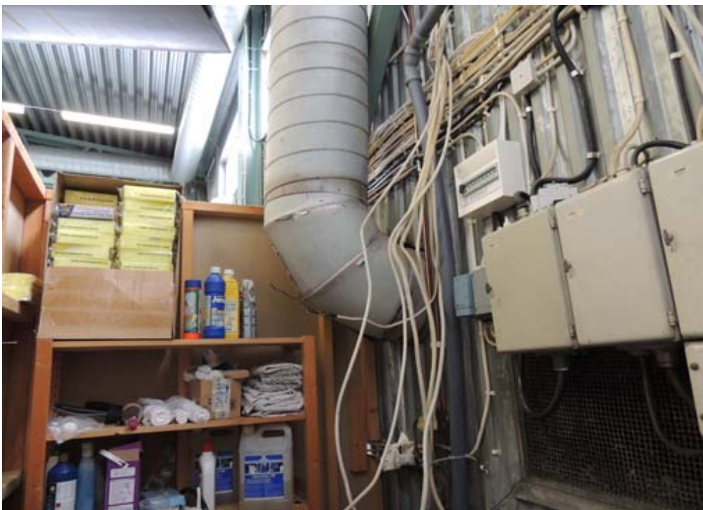
Bild 4 Genomfart pannrum – hangar
