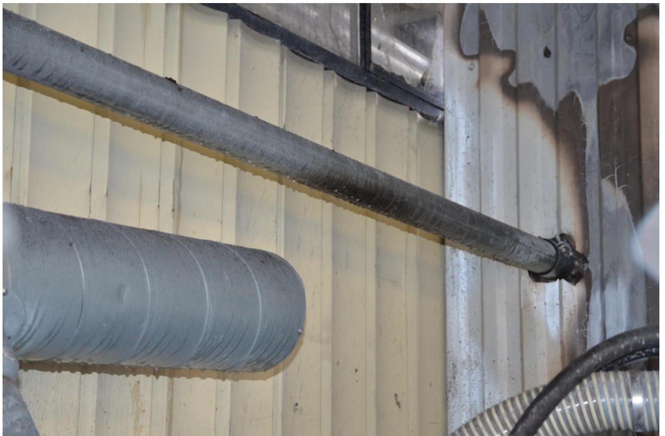
Värmepåverkat mindre rör genom södra gavelväggen
