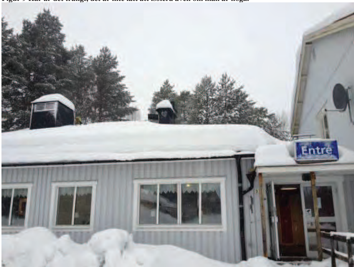
Figur 10 Restaurangdelen är till vänster, vandrarhemmet till höger i två plan. Det finns inte en chans att klara brandspridning genom fönstret vid parabolantennen, genom B30-dörren i den gemensamma entrén och takutsprånget
