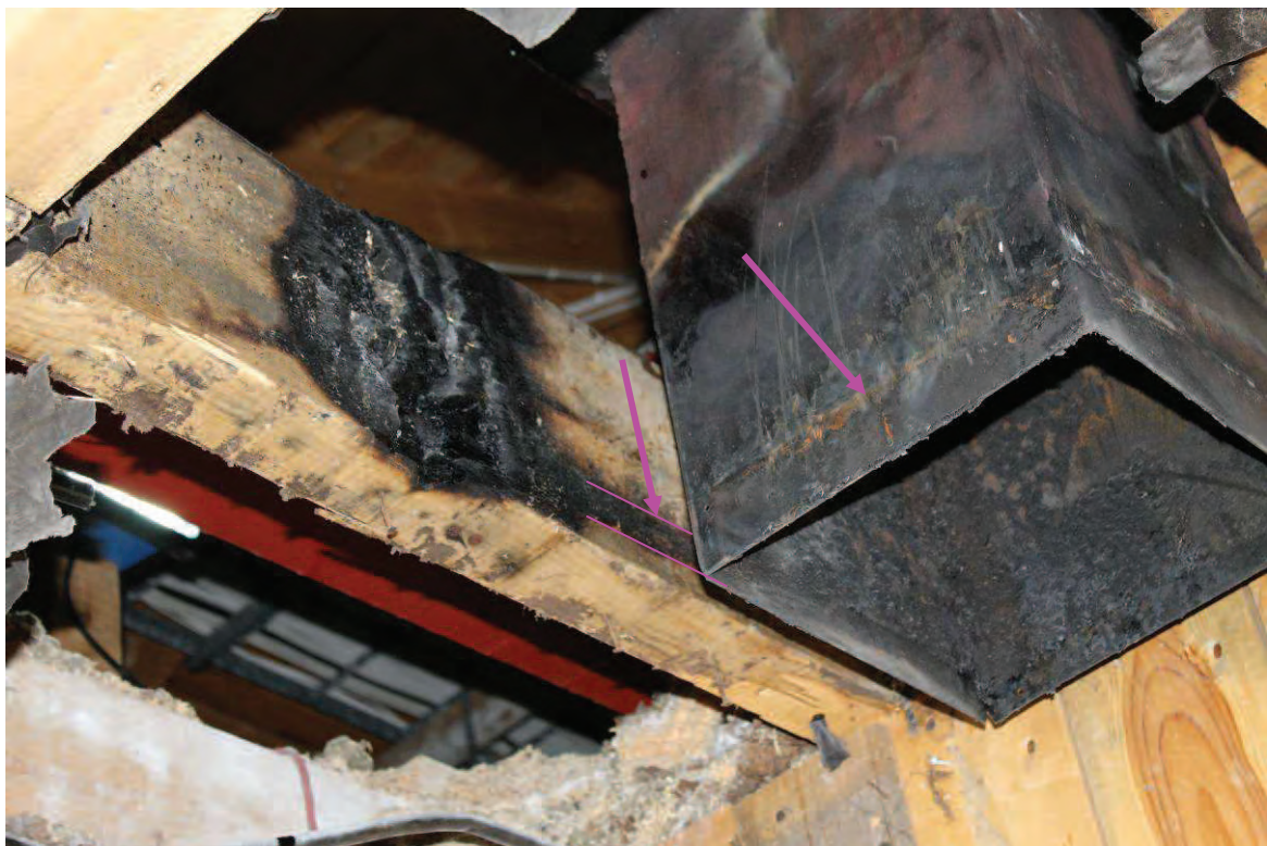
Figur 4 Den vågräta linjen på röret sammanfaller med den vågräta brända linjen på takstolens underram.
