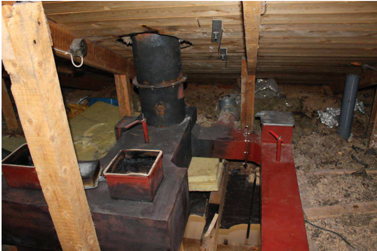
Figur 7 En översiktbild visar ventilationsanläggningen på vinden. Den var vid brandtillfället isolerad med stenullsmattor i dubbla lager. All färg är i det närmaste bortbränd. Det röda röret med spjäll går till köksfläkten i angränsande rum. Figur 2 visar hur installationen såg ut vid brandtillfället.
