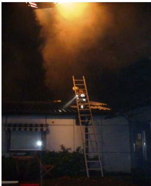
Bild 5. Takarbete på huvudbyggnaden
