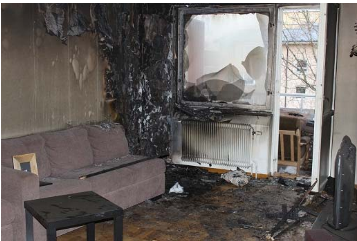
Översiktsbild på brandrummet.
