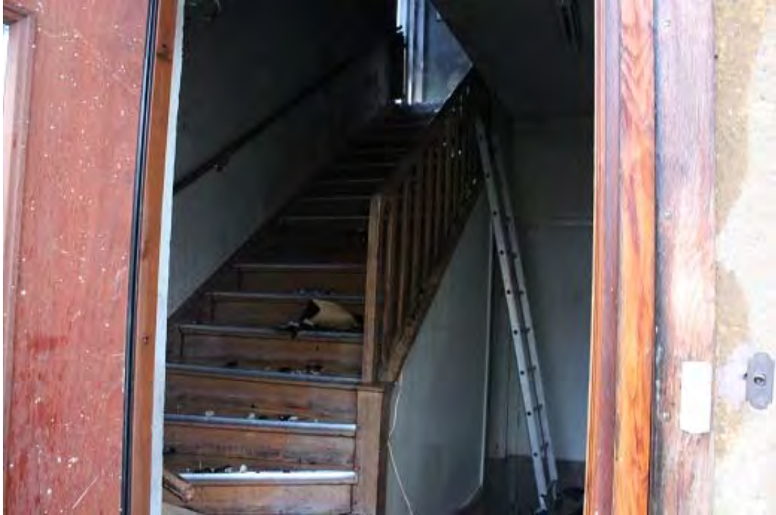
Bild 1: Trapphuset från entren, och upp till övervåningen.
