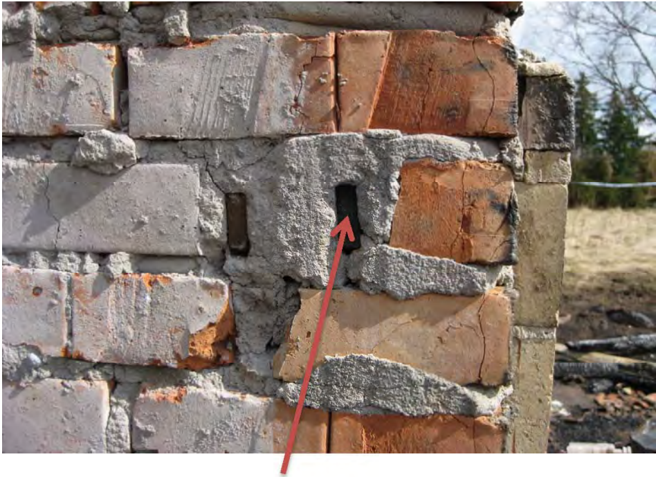
Här finns järn som håller kronan över den öppna spisen. Denna har suttit under träregeln till vägg för dörrposten till vardagsrummet. Även den blir uppvärmd, men har troligtvis inte med brandstart att göra.
