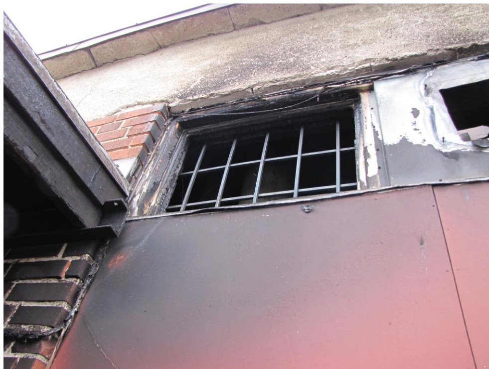
Bild 4. Fönster från lokalen.
