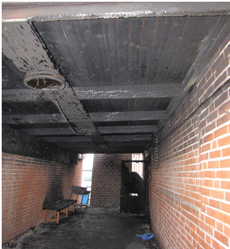
Bild 2. Brandspridning via tak mot dörr och fönster till lokalen.
