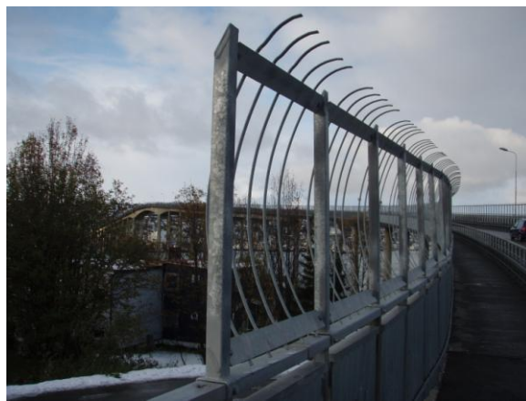
Påbyggnadsstaket på Tromsöbron i Norge 21
