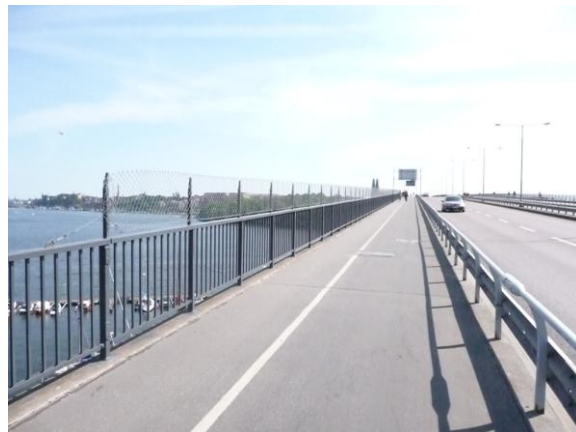
Befintligt påbyggnadsstaket ovanför båtklubben
