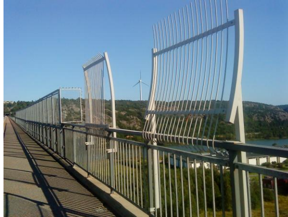
Prov på påbyggnadsstaket monterade av vägverket vid Angeredsbron i Göteborg 20
