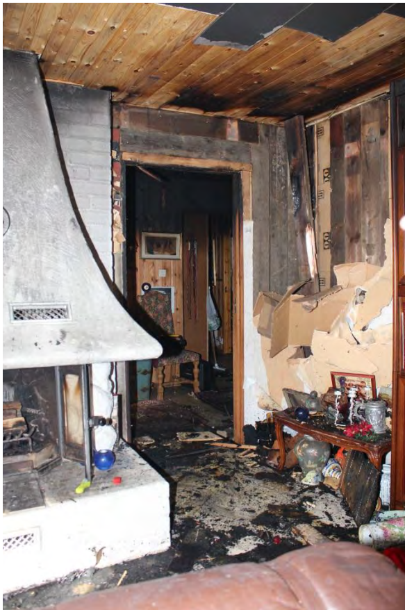
Brandskador i vardagsrummet.
