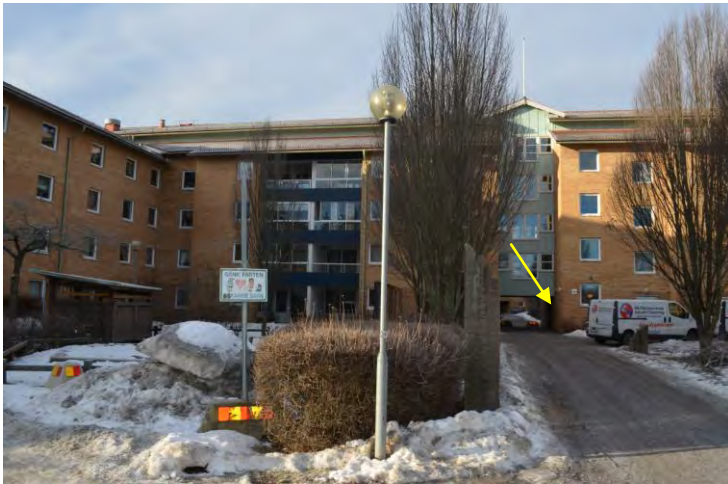
Huset från framsidan. Ingång till trapphuset markerat med pil. Drabbad lägenhet fönster mot innergård.
