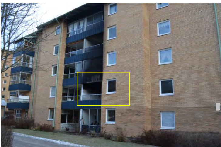
Brandutsatta lägenheten från baksidan (Obs infüllda balkongerna )
