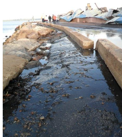
Bild 11: Släckvattenläckage till Oceanhamnen
