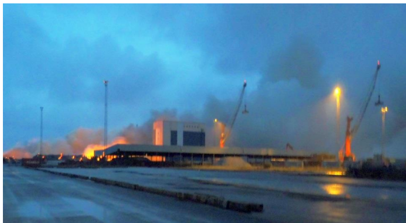
Bild 4: Större delen av byggnaden nerbrunnen på lördagmorgon - 06:26 - 10222
