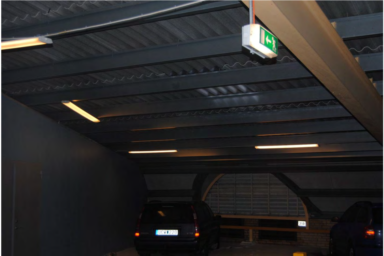
Bild 3 visar takkonstruktionen, gula I-balkar, galvaniserad plåt balkar och sedan takpannorna.
