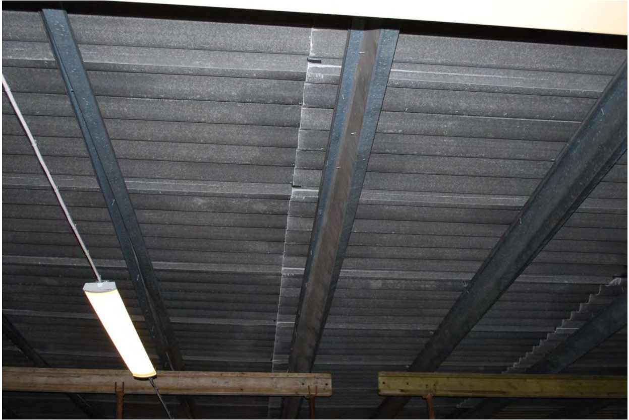
Bild 5 Här syns de vikta stålprofilerna som stöttats upp av träreglar.
