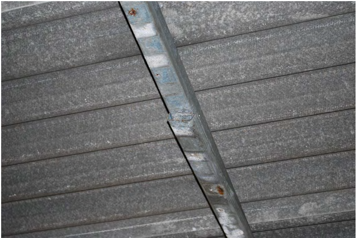
Bild 8 Här syns hur en galvad stålprofil släppt i en skarv.
