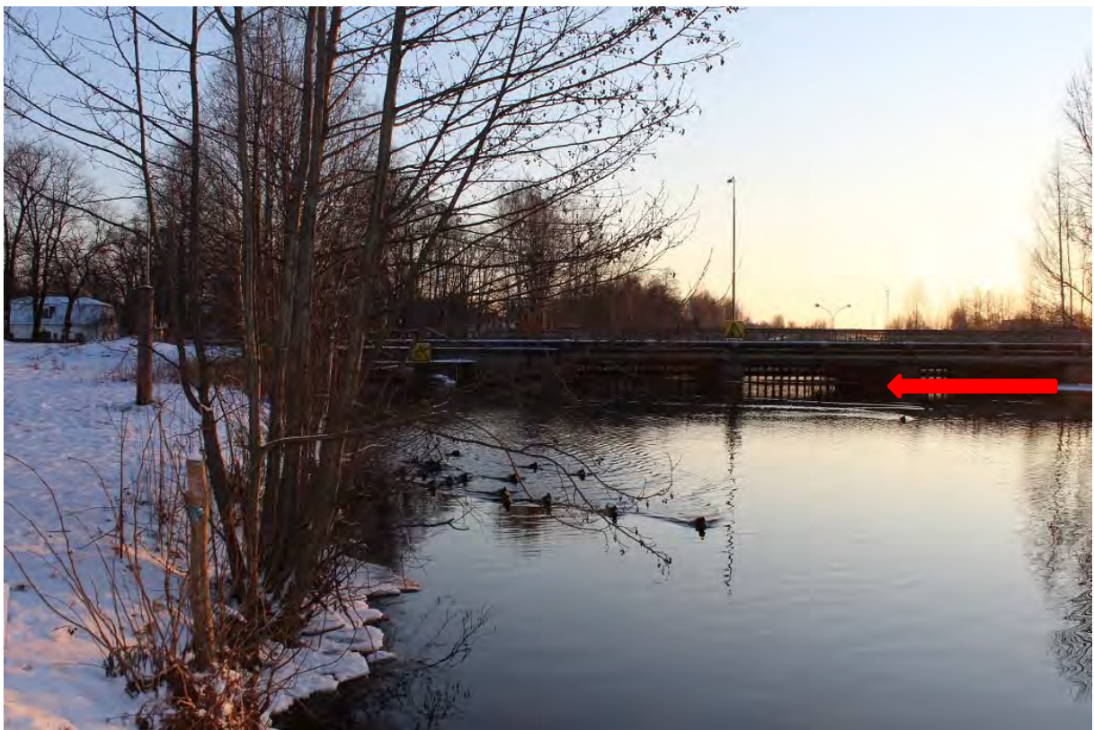
Bild 6. Den här bilden är tagen från iläggningsplatsen för kanoter mm, här kan man se tydligt att det finns galler på dom andra utloppen från älven.
