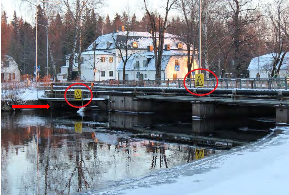
Bild 1. Pilen visar där kanoten åkte in under bron, Två st. varningsskyltar finns på bron som indikerar strömmande vatten.
