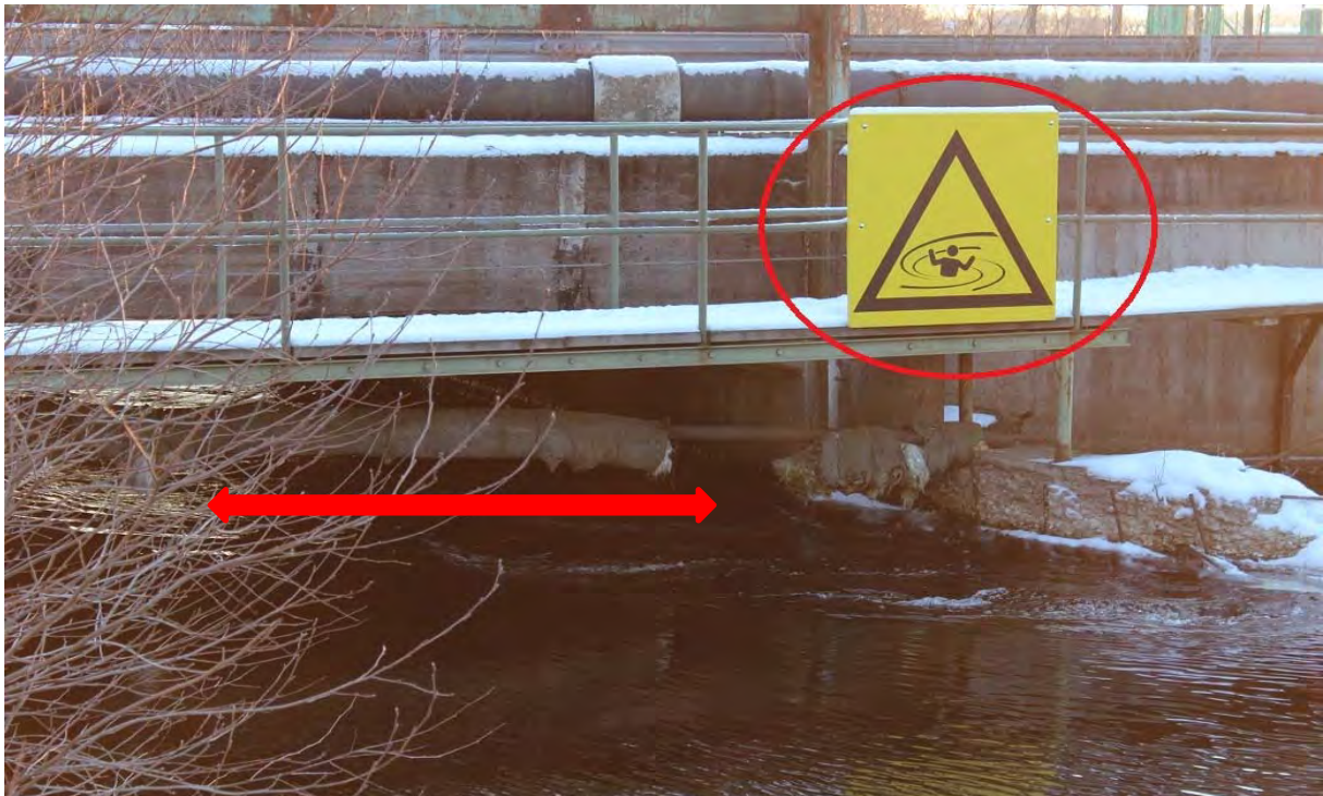
Bild 2. Ett vaderat stålör finns som ett stopp om någon skulle driva in mot kraftstation.
