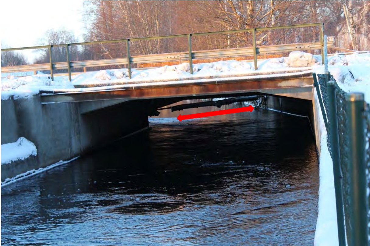
Bild 3. Bild från andra sidan vägen, man kan se skyddet under bron.
