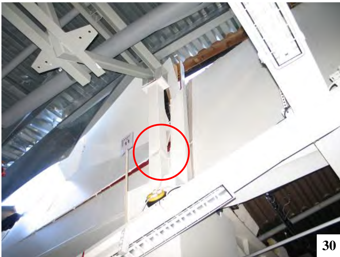
Pelare 11E i ringen är det ett veck på pelaren och stålfacksbalkar.
