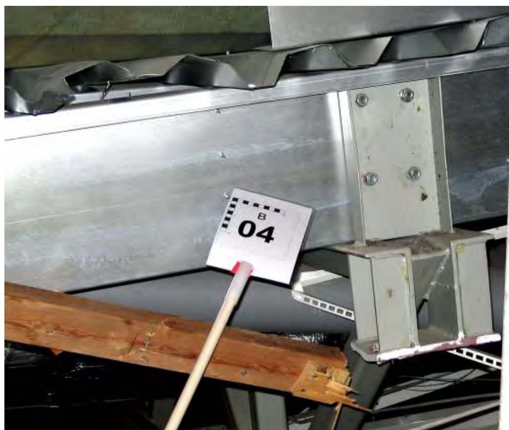
Pelarförankring 5E och stålacksbalkar
