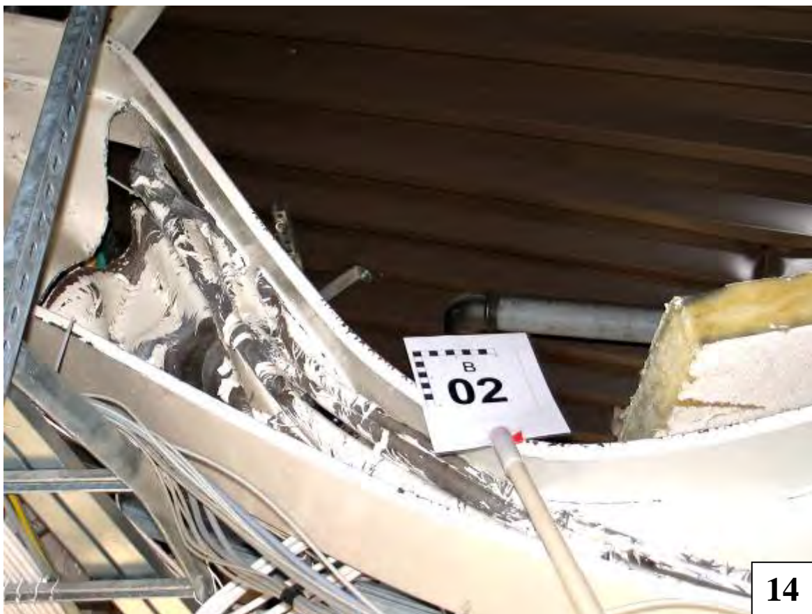
Takstolen i närbild vid pelaren 4E.
