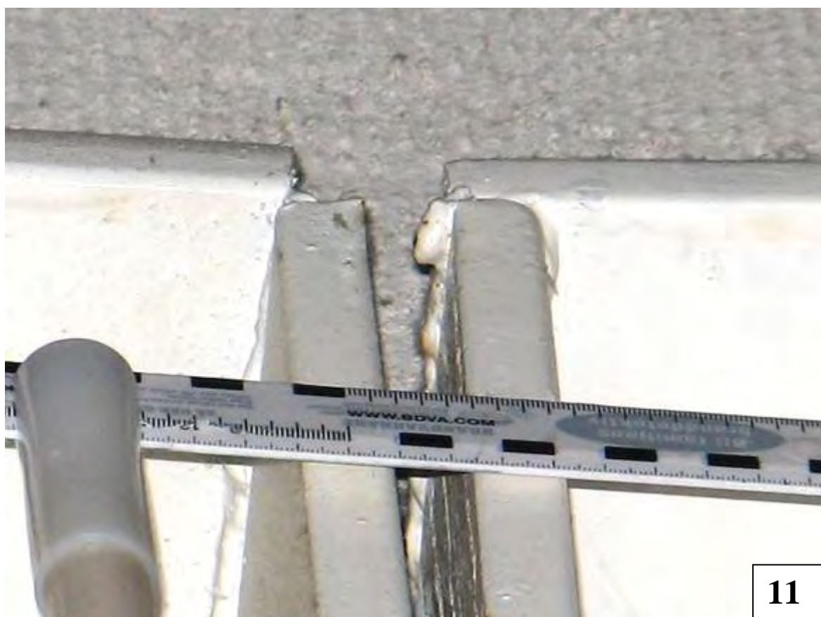
Pelare 3C, takstolens förskjutning kan mätas.
