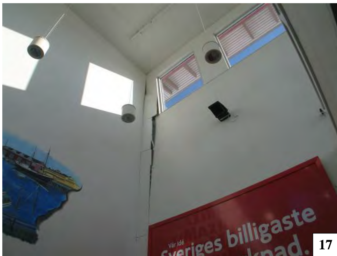
Tornet åt öster vid entrén invändigt, sprickan tagen i en annan vinkel.
