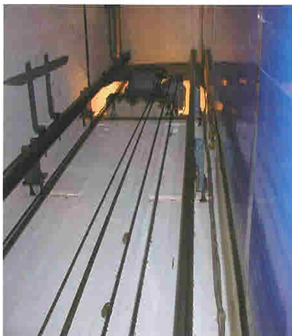
Hisschaktet sett nedifrån.
