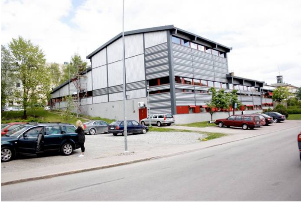
Bild 3, simhallen. Angreppsväg källardörren.
