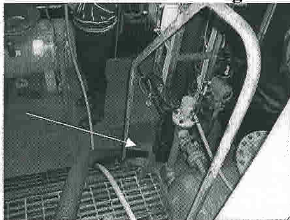
Tankutrymmets invallning, där vissa komponenter hade förstörts av saltsyran, bl.a. hade aluminiumlocket till pumpgropen fränts bort. Nog så anmärkningsvärt!
