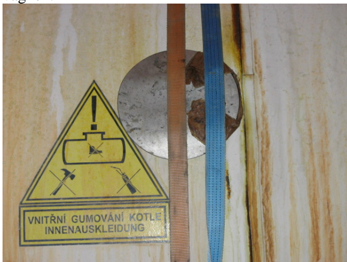
Bild 2.5 – Tätning av hålet genomförd.
