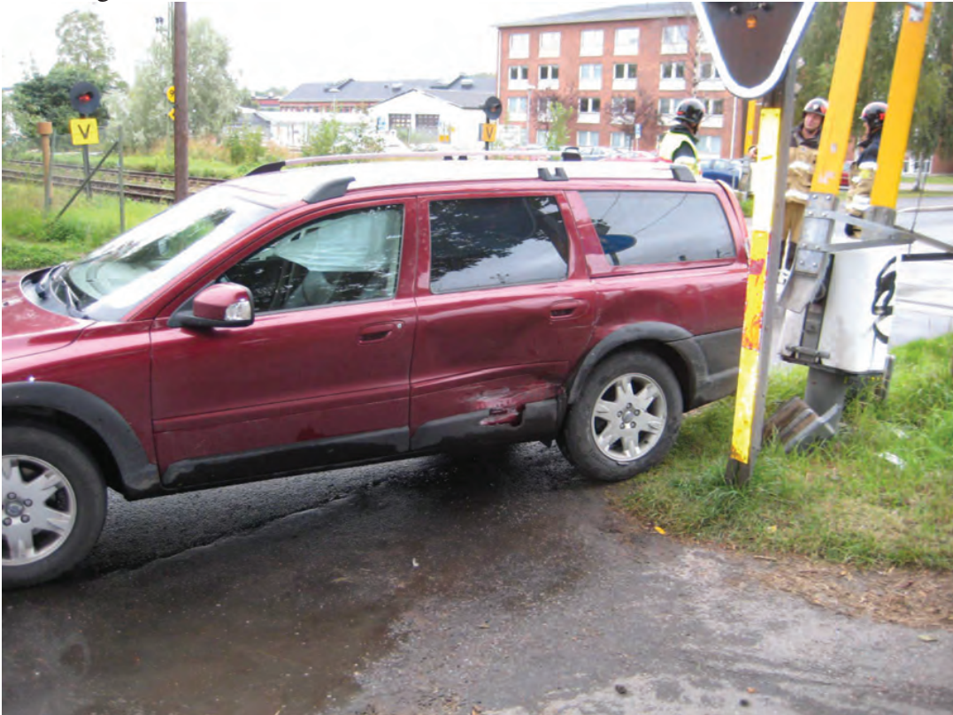
Figur 1 Bilen sladdade runt och träffade järnvägsbommens fundament. Den kunde inte fällas när bilen stod där.
