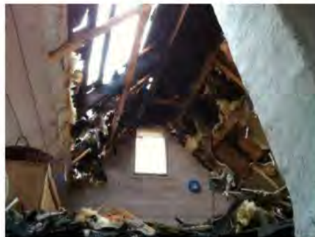
Friläggning av takkonstruktionen
