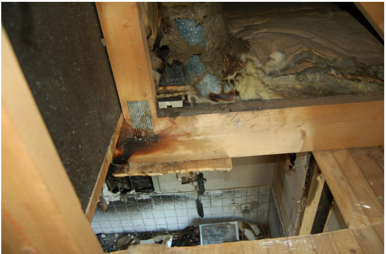
Köket sett genom bjälklaget. I bildens mitt syns delar av bjälklagets brandskador.
