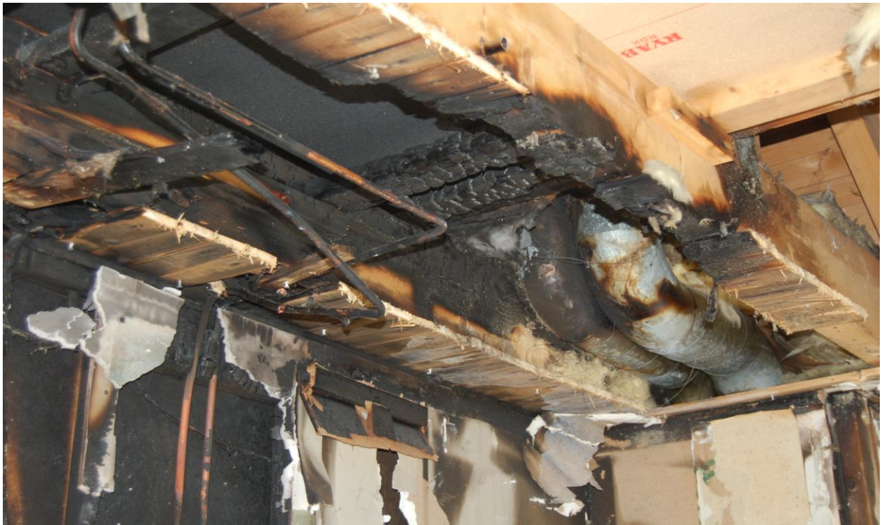
Bjälklaget vid överskåpen sett underifrån.
