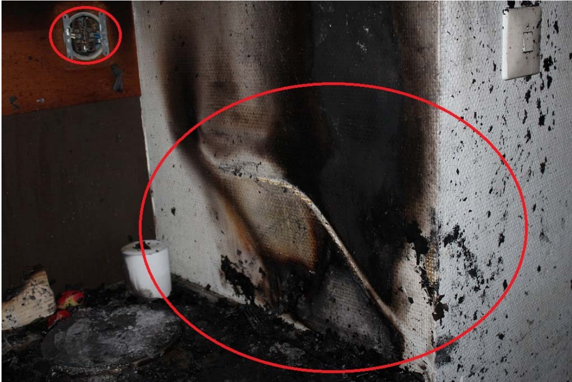
Bild 5. Här kan man se tydligt att kabeln från fryssboxen har legat på pizzakartongerna som i sin tur låg placerade på spisplattorna. Lilla röda ringen är uttaget som kabeln var inkopplad i.
