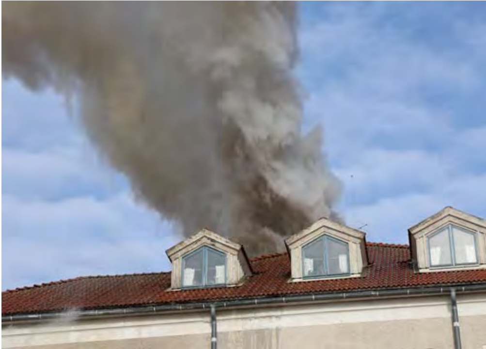
Bild från västra sidan av byggnaden.
