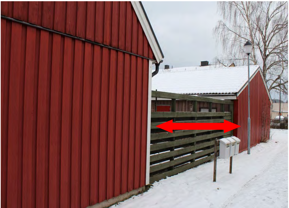
Bild 14 6,50 m. mellan Radhuslängan och garagelängan.
