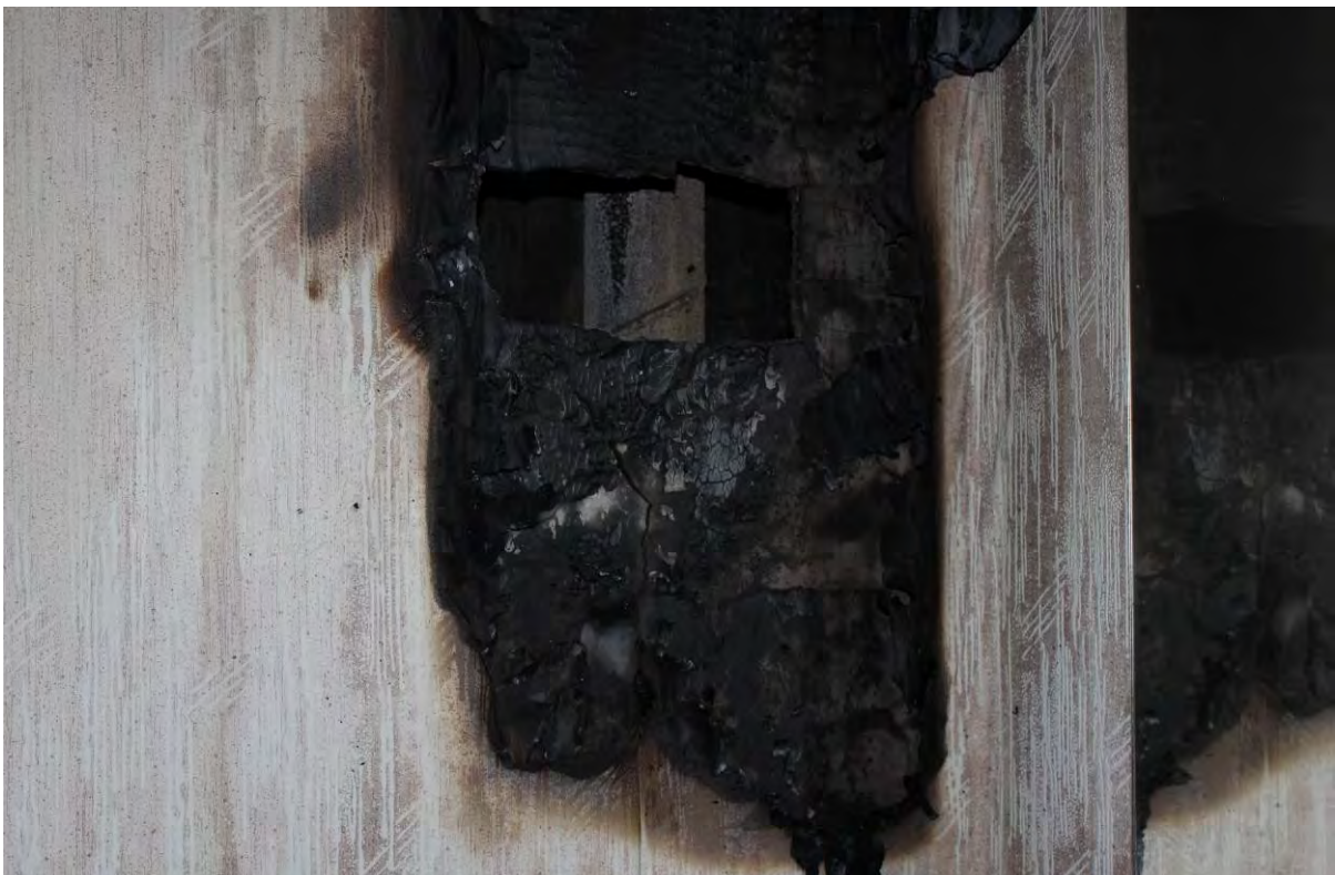
Bild 18. Brandspridning via mellanväggar (ventilation)
