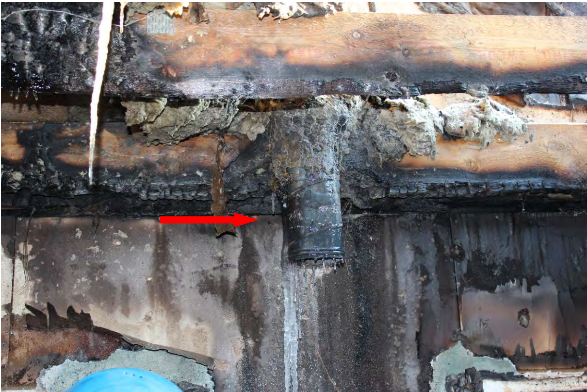
Bild 12. Utsugsrör till köksfläkten.
