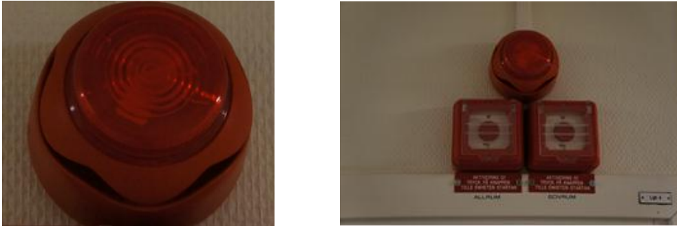
Bild [13] Manöverpanel för manuell aktivering, avaktivering av sprinklermunstycke samt larmdon.
