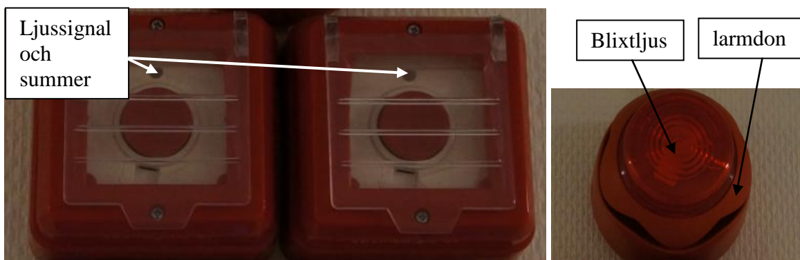
Bild [9] Ljussignaler i manöverpanelerna.
