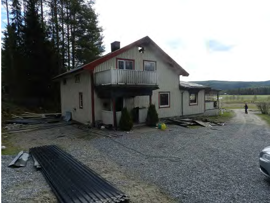
Bild 3. Fastigheten från östlig sida där fönstret gick sönder vid framkomst.
