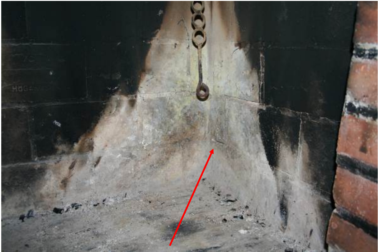
Bild 5 Spricka mellan tegelstenarna i eldstaden
