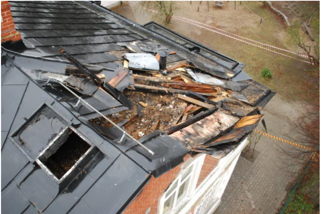
Angreppsväg genom tak.
