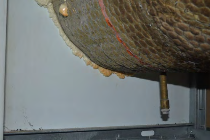
Undre del av im/rökanalen Isleringen slutar på insida brännbart material och tätat med fogsium
