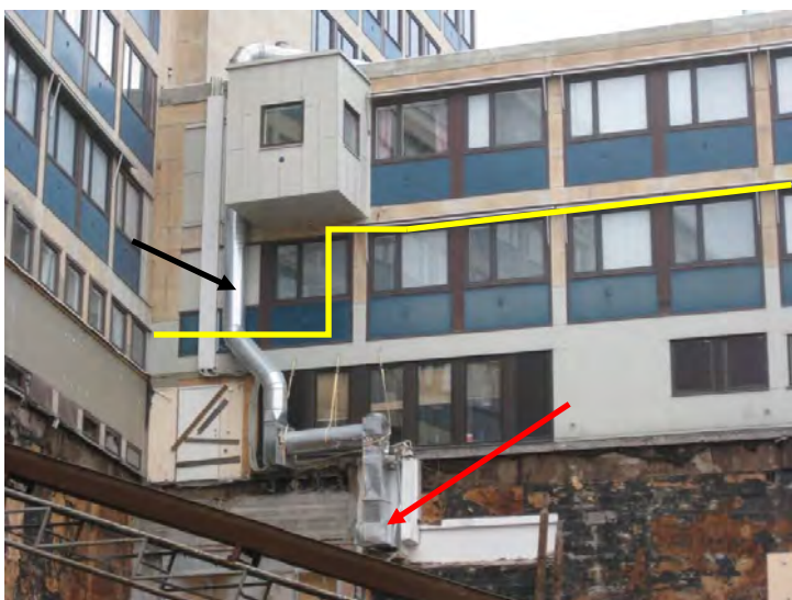
Röckkanal innan ombyggnad. Utloppet (röd pil) är i kolgrillens kök som ligger i markplanet. Svart pil markerar nya utloppet för röckkanal. Gul markering visar var taket på den nya biografen slutar.
