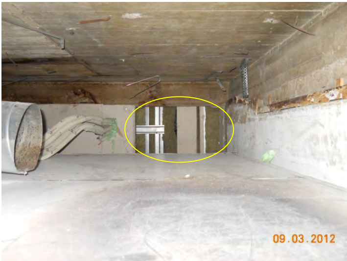
Utrymmet då kanalen är nedmonterad. Stål och träeglar på det nya biobygget i markplan.
