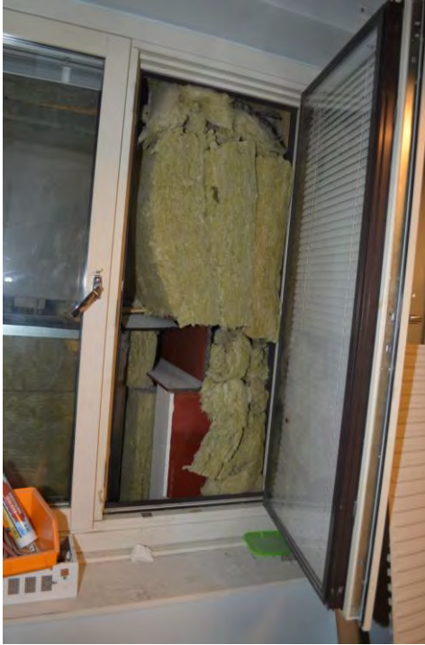
Öppningsbart fönster in mot det nya biografbygget. Träreglar helt synliga.
