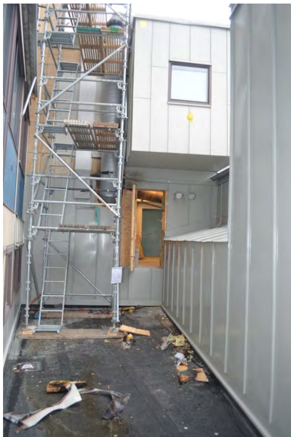
Ny dragning av rökanal pga. biografbyggnad som syns i grå plåt till höger på bild. Ny dörr har öppnats upp på våningen ovanför då taket har höjts på byggnaden
