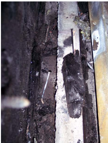
Bild 4 Här ser man tre spikar två som är utan omslutande virke och en som sitter i en kolbit
