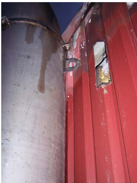
Bild 2 Här syns att ljuddämparen ligger, mot plåten, det gjorde den under hela sin längd.
