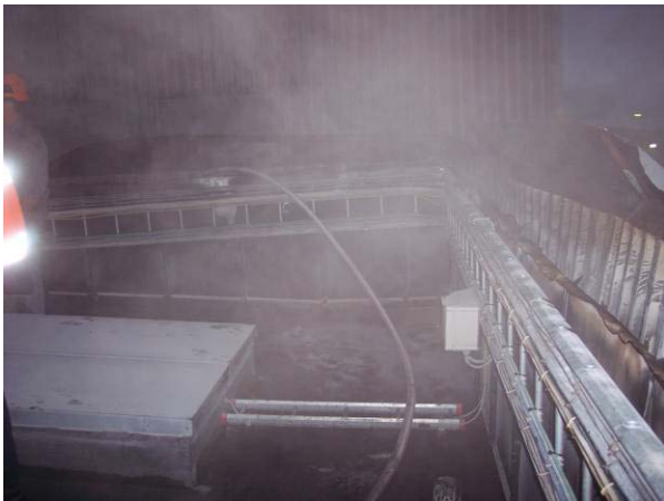
Bild 6 Bilden visar den norra väggen (till höger) och den västra väggen (rakt fram)
