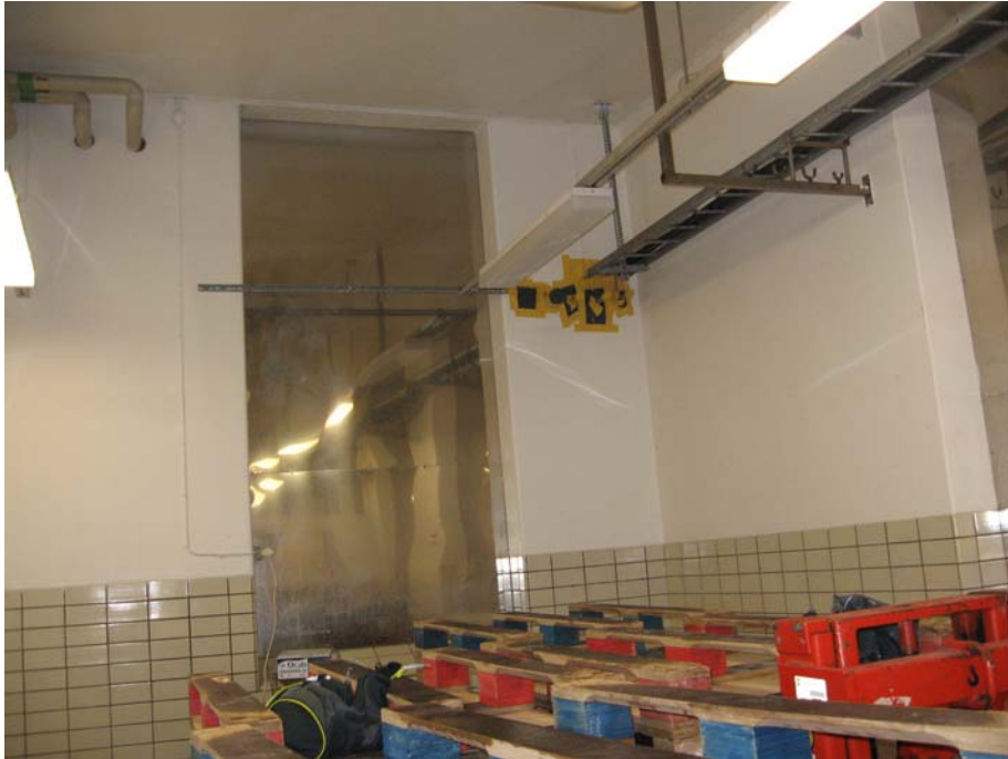
Bild 5. Ölandsosts lokaler där otätheter i genomföringar i brandcellsgräns tätades under branden för att minska rökspidningen.
