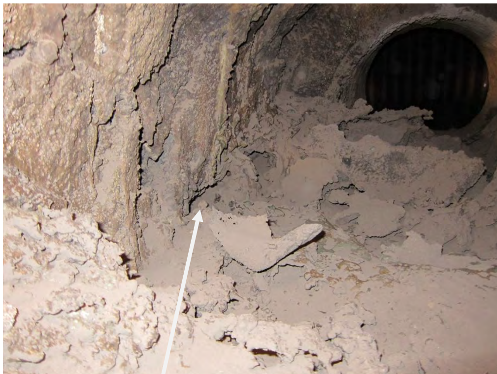
Bild 3: Visar var primärluften tillförs i brännaren.
