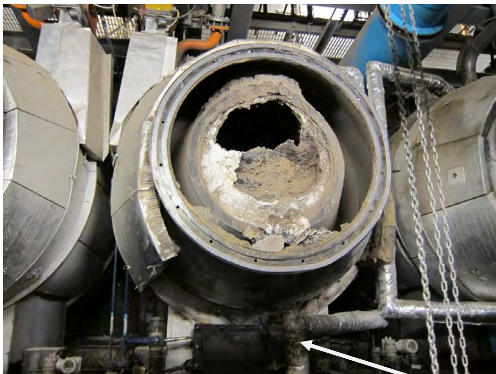
Bild 1: Visar gaveln på brännare 2 efter att den öppnats. Pilen visar primärluftens anslutning.
