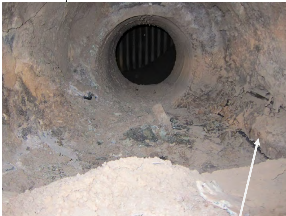
Bild 4: Visar en rengjord brännare, där man kan se primärluftkanalerna nere till höger i brännaren.
