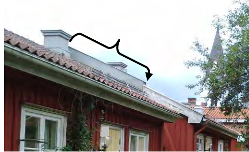
Fig 8: Förstärkning av brandcellsgränsen.
