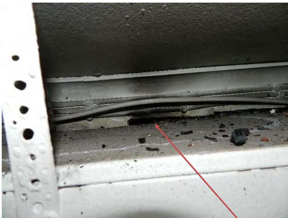
Bild 8. Primärbrandplats, glipan i väggen där branden startade från garaget.
