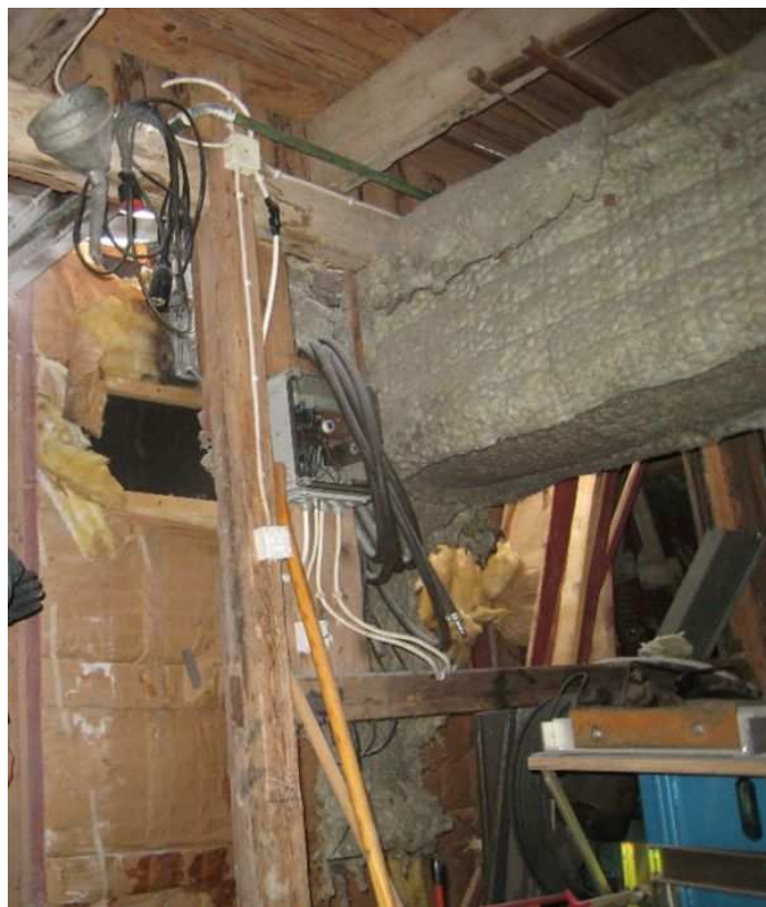
Bild 5. Lufttrummans genomföring.
