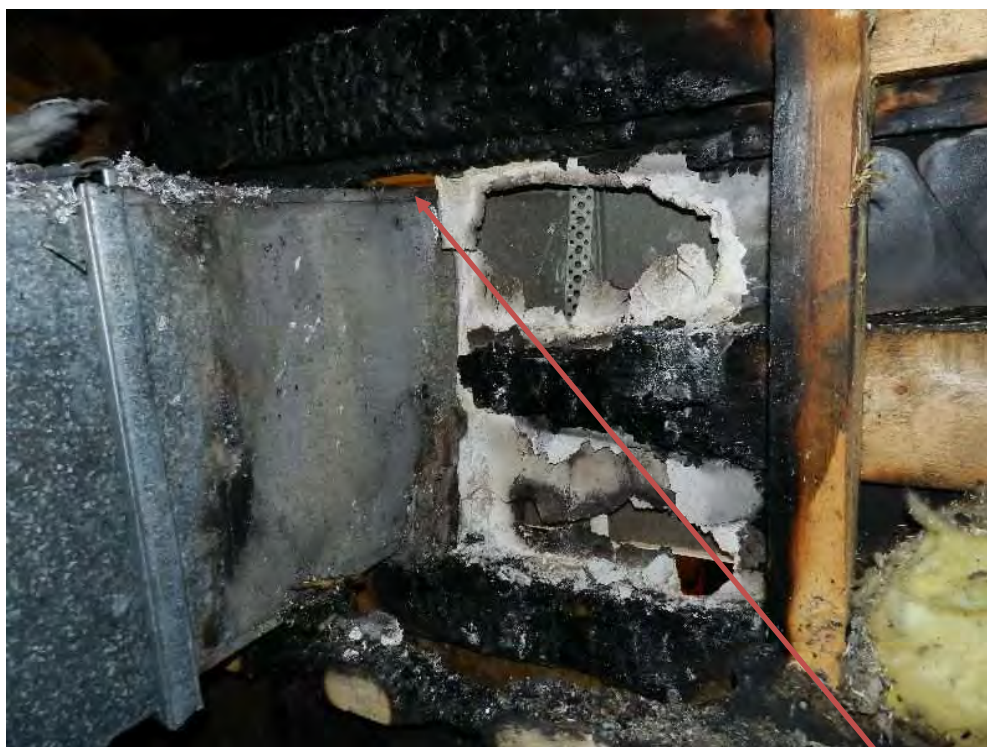
Bild 6. Primärbrandplats, glipan i väggen där branden startade.
