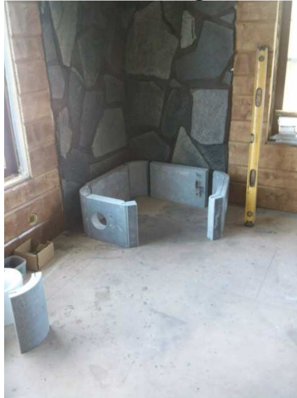
Bild 1. Ugnen är uppmurad direkt på spånplattegolvet
