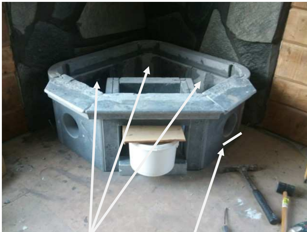
Bild 2. Gjutning i dessa utrymmen. Till denna höjd
