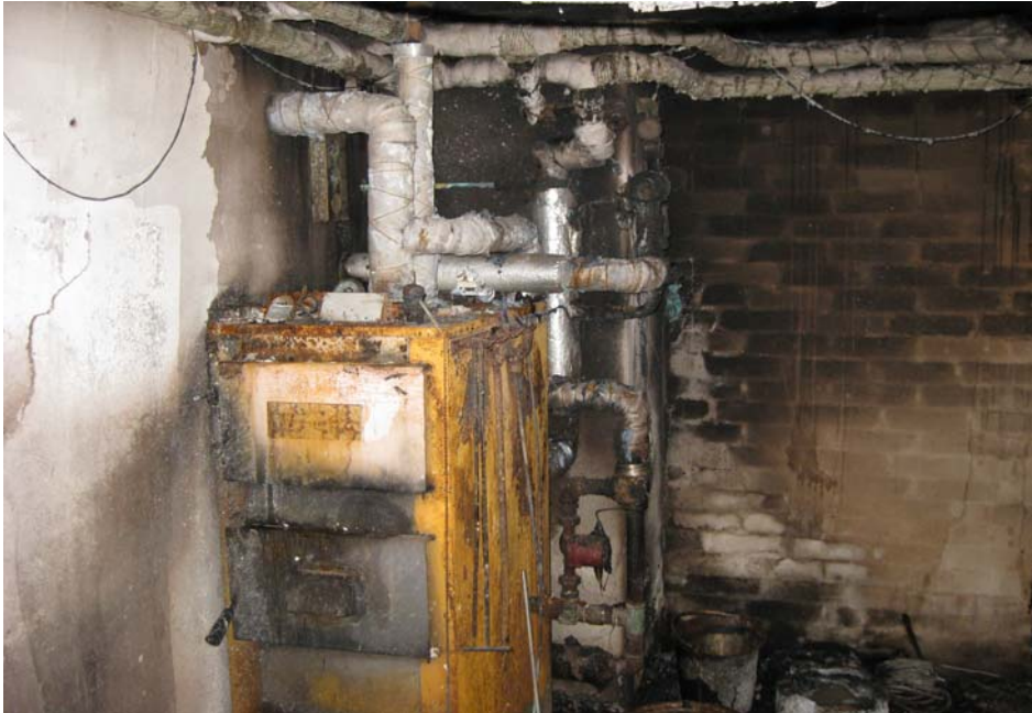
Den vedpanna som använts som värmekälla i huset. Vedpanna och accumulator-tankar var placerade i källaren.
