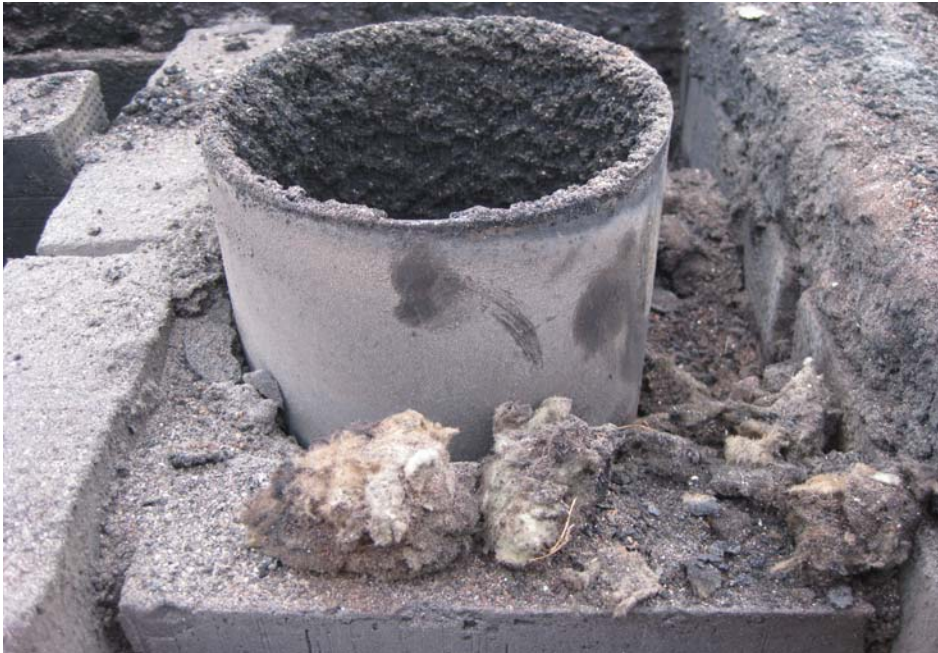
Ägaren har stoppat i isolering 20 cm. ner runt pipan.
